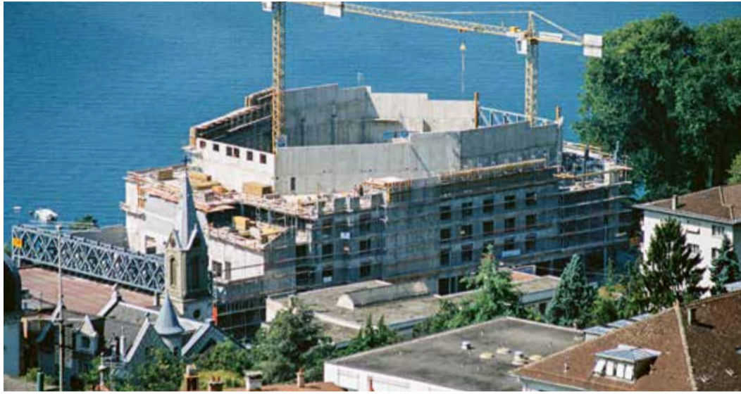
CONSTRUCTION DE MC3 - 1992
