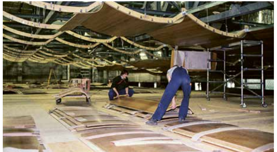
DANS LE PLAFOND DE L'AUDITORIUM STRAVINSKI - 1992
