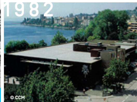
1982 © CCM Extension et naissance du bâtiment B
