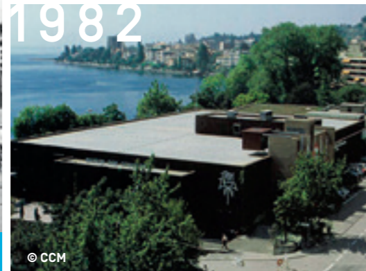
1982 © CCM Extension et naissance du bâtiment B
